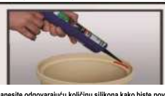
Nanesite odgovarajuću količinu silikona kako biste povezali elemente. Višak silikona uklonite spužvom.
