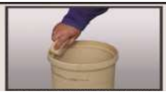
Prije montaže očistite rub cijevi pomoću spužve
